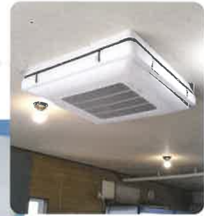
新設の業務用エアコン。涼しい!省エネ!ワンコたち大喜びです。
