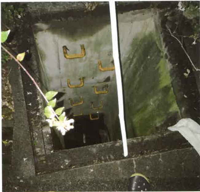
【グレーチングを開けた状態の竪穴】
