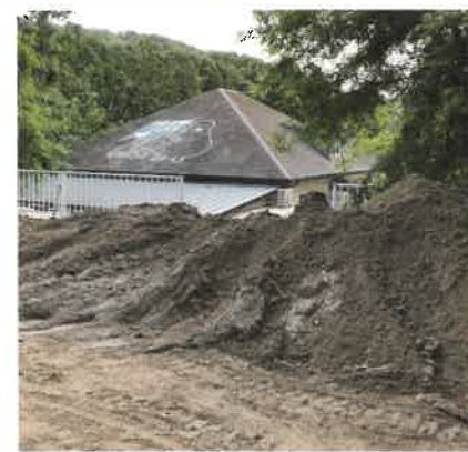
溝から掻き上げた土砂。
